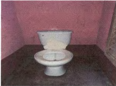
Foto 13: sustitución de inodoro baño de niñas.
