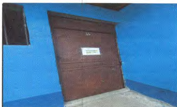
Foto 4: Sustitución de puerta de metal en aula
