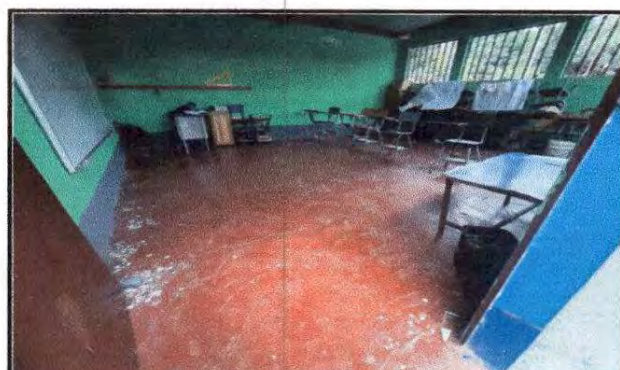
Foto 10: Sustrucción de piso cerámico.
