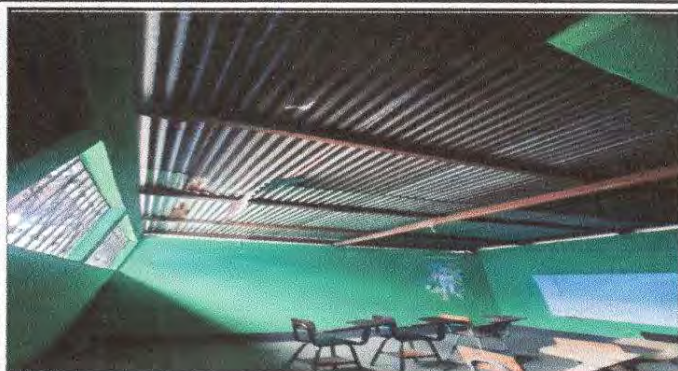
Foto1: Cubierta de lamina sustitución en aula.
