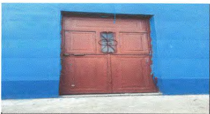
Foto 5: Sustitución de puerta de metal en aula.
