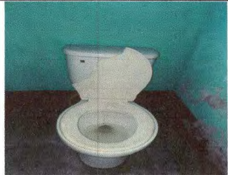
Foto 14: sustitución de inodoro baño de niños.
