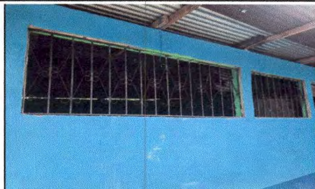
Foto 8: Sustrucción de balcones de metal.
