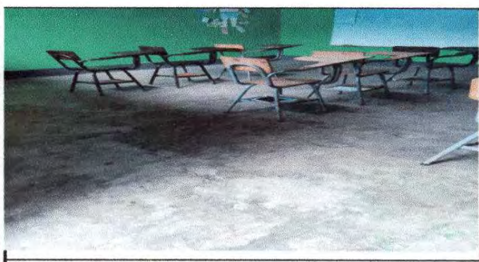
Foto 11: Sustrucción de piso cerámico.
