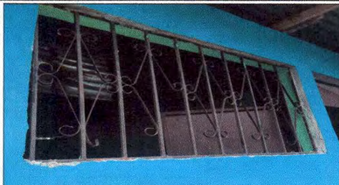
Foto 7: Sustrucción de balcones de metal
