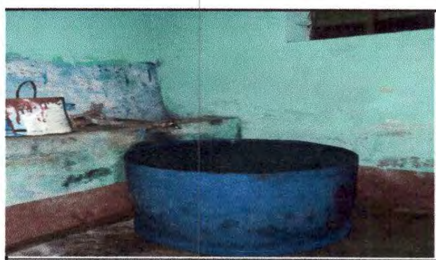
FOTO 12: Sustrucción de lavamanos
