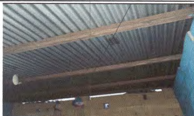
Foto 2: Cubierta de lamina sustitución en aula.
