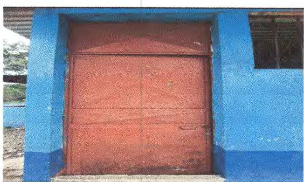
Foto 6: Sustitución de puerta de metal en dirección.
