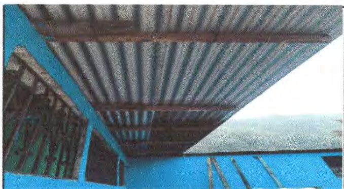
Foto 3: Cubierta de lamina sustitución en aula.
