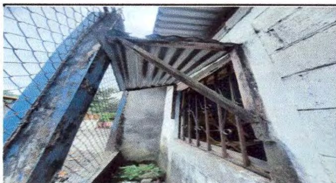
Foto 9: Sustrucción de balcones de metal.
