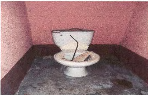
Foto 15: sustitución de inodoro baño de niñas.
